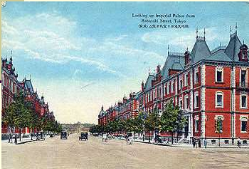
Siège du Mitsubishi zaibatsu , 1923
